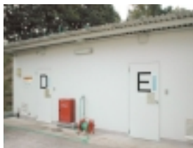
PCB保管倉庫
