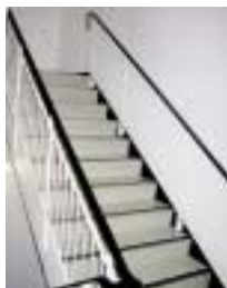
階段の手すり設置例
