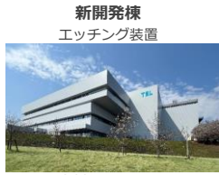
宮城県黒川郡 2025年4月 竣工
