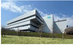
宮城県黒川郡 2025年4月 竣工
