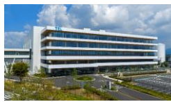
熊本県合志市 2025年10月 竣工
