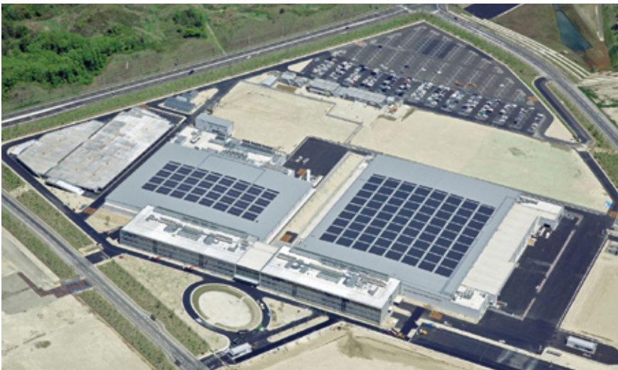
建設中のプラズマエッチング装置の新生産拠点 東京エレクトロン宮城(株)。開発と製造を一体化することで事業強化を狙う。環境対応のために屋根に太陽光発電設備を備える。
