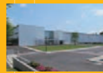
テクノロジーセンターつくば
