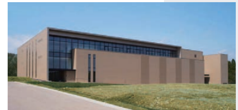
東北大学国際集積エレクトロニクス研究開発センター 研究開発棟 2013年4月竣工
