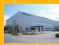
東京エレクトロン九州新生産棟完成
