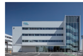
東京エレクトロン テクノロジーソリューションズ 穂坂事業所 新開発棟 (2023年7月竣工)
