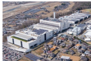
東京エレクトロン テクノロジーソリューションズ 山梨事業所 生産棟 2020年8月 稼働開始
