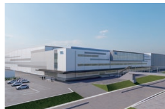
東京エレクトロン テクノロジーソリューションズ 東北事業所 東北生産・物流センター（仮称） 2025年秋 竣工予定
