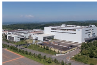
東京エレクトロン テクノロジーソリューションズ 東北事業所 生産棟 2020年7月 稼働開始
