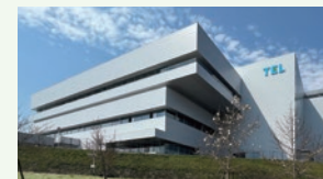
東京エレクトロン宮城 第3開発棟
