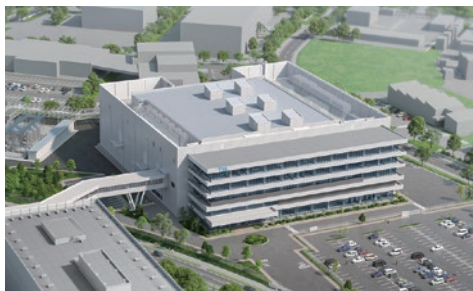
東京エレクトロン九州 開発新棟
