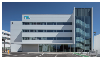
東京エレクトロン テクノロジーソリューションズ(株) 穂坂事業所 新開発棟
