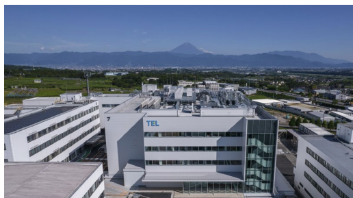
山梨県韮崎市 2023年7月 竣工
