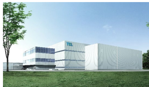
宮城県黒川郡 2025年春 竣工予定
