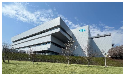
宮城県黒川郡 2025年4月 竣工
