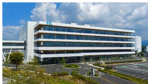
熊本県合志市 2025年10月 竣工
