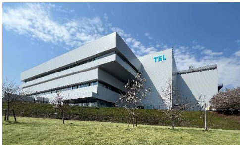
宮城県黒川郡 2025年4月 竣工
