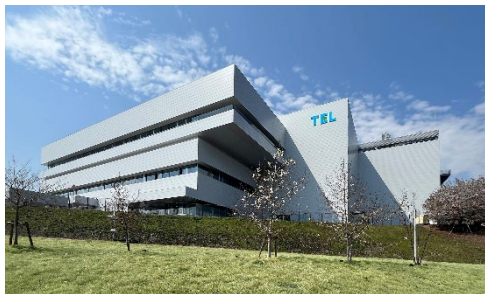
宮城県黒川郡 2025年4月 竣工
