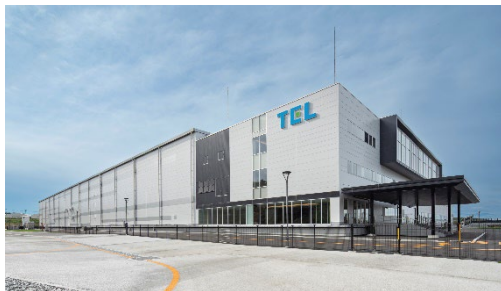
岩手県奥州市 2025年11月 竣工
