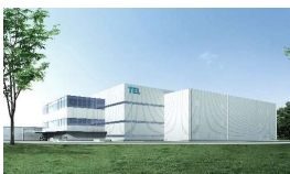
宮城県黒川郡 2025年春 竣工予定
