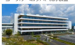
熊本県合志市 2025年10月 竣工
