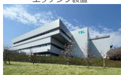
宮城県黒川郡 2025年4月 竣工
